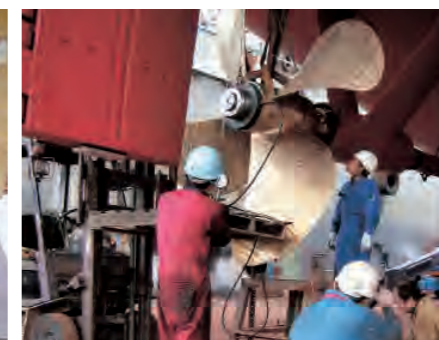
プロペラ軸径φ240のプロペラの油圧押し込み
