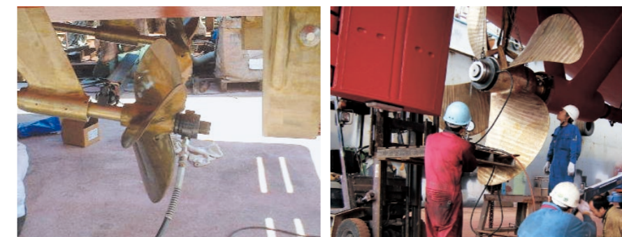
プロペラ軸径φ55のプロペラの油圧押し込み
